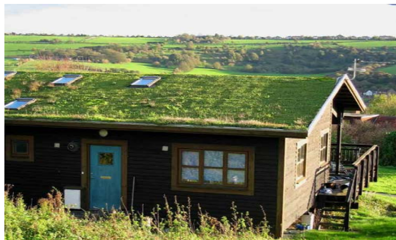
Những mái nhà giúp bảo vệ môi trường
